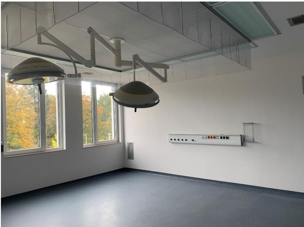
Bild: OP 4 (Kat I A mit Laminar-Airflow)
